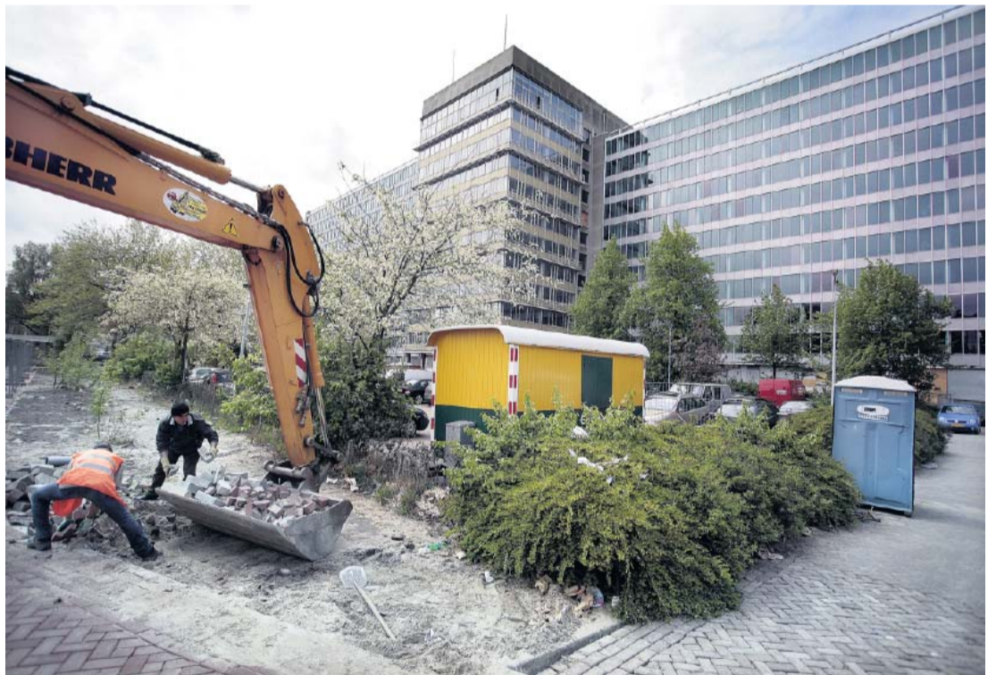
Het voormalige GAK-gebouw in de Amsterdamse wijk Bos en Lommer.
